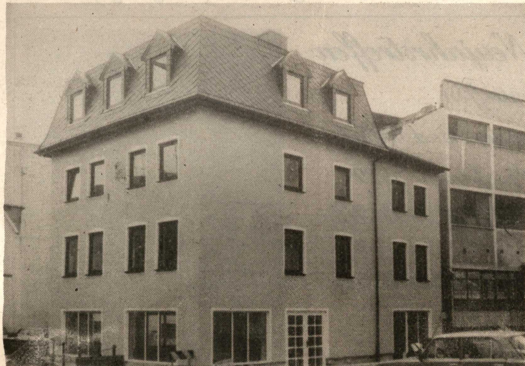
Neu und alt nebeneinander. Die Sanierung wird fortgesetzt. Die Stadt hat Sanierungsgrundstücke gekauft.
