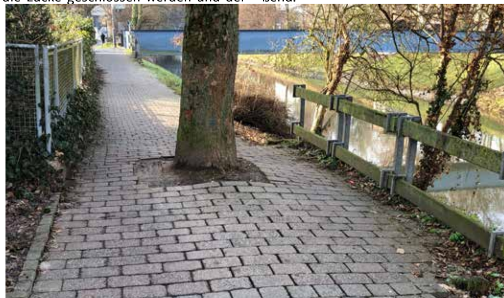
Stadtseitiger Niddauerweg vor dem Umbau
