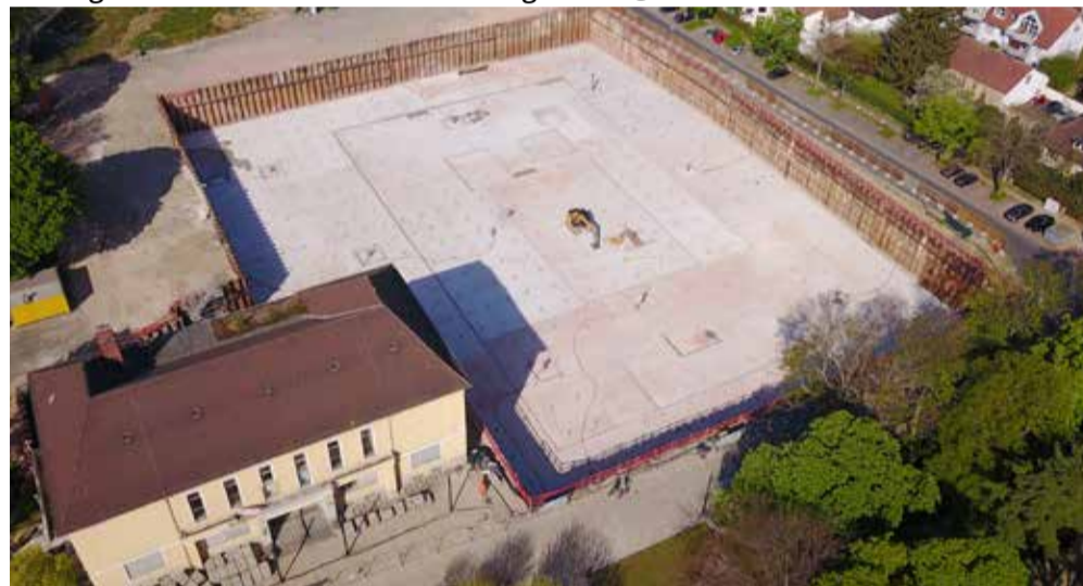
Das historische Kurhaus mit dem Fundament der neuen Tiefgarage.
