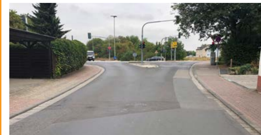
Keine Straßenbeiträge mehr in Bad Vilbel
