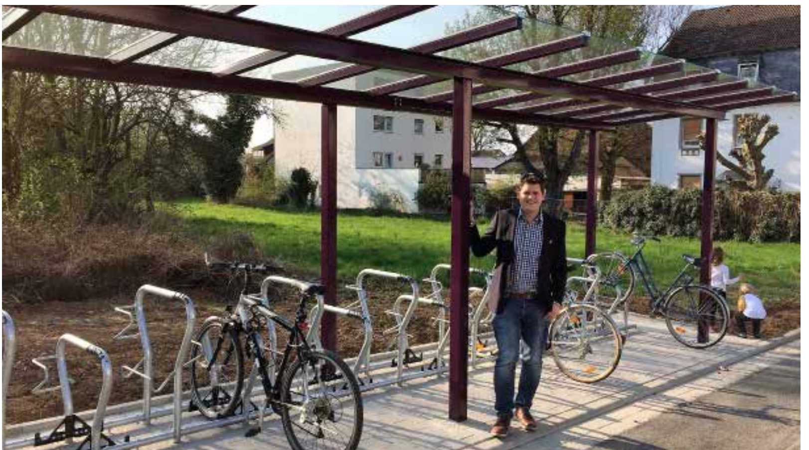
Die neue Radabstellanlage am Bahnhof in Gronau
