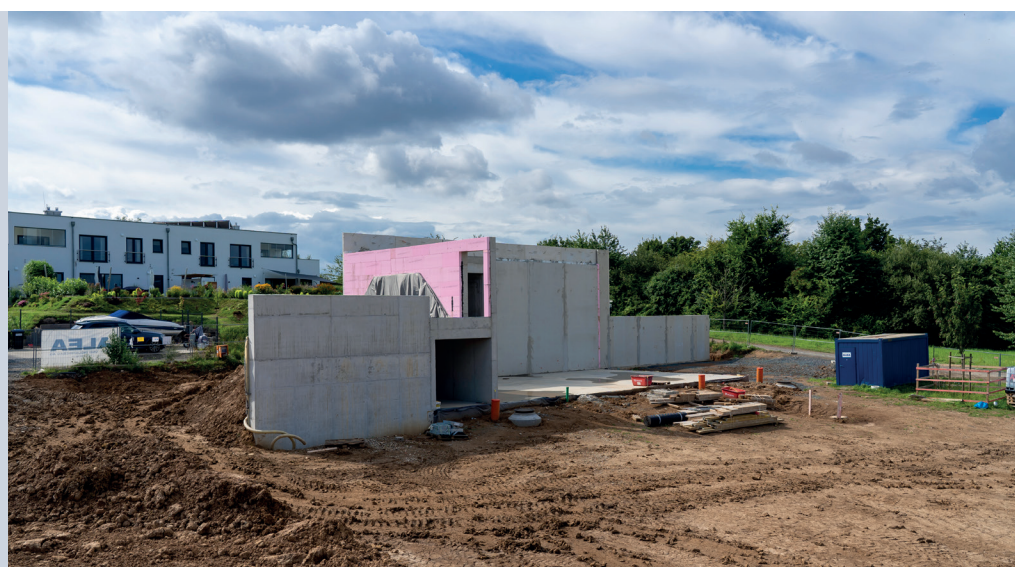
Im Mai haben die Arbeiten begonnen. Nun stehen schon erste Wände.
