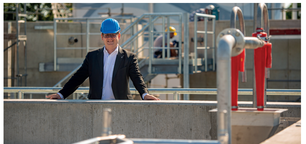
Erster Stadtrat Wysocki sieht sich den Baufortschritt an.
