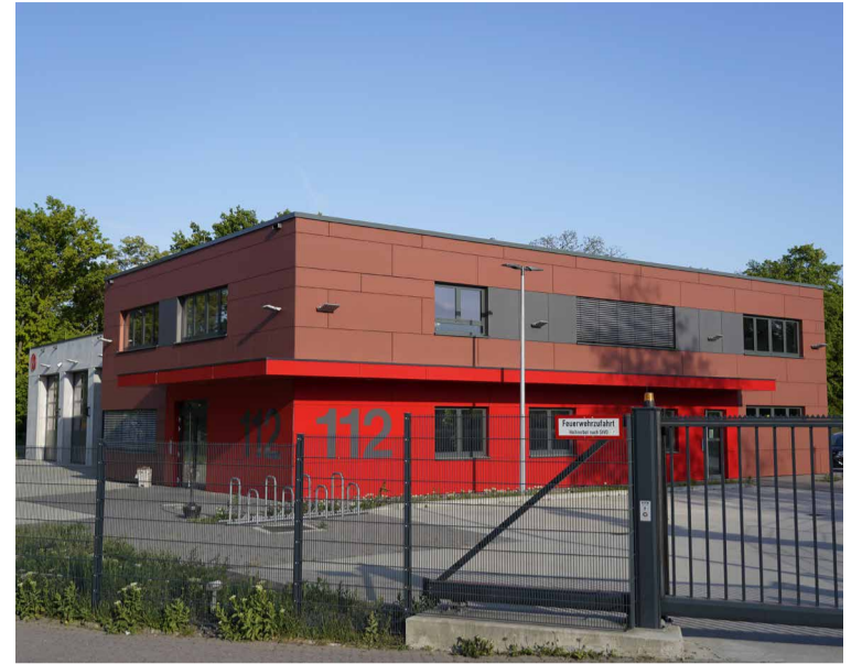
Ein moderner Feuerwehrstützpunkt für den Heilsberg.
