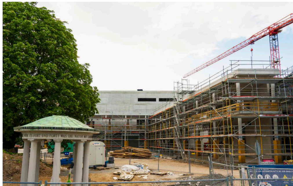
Das verbindende Element, die gläserne Orangerie, nimmt Form an.
