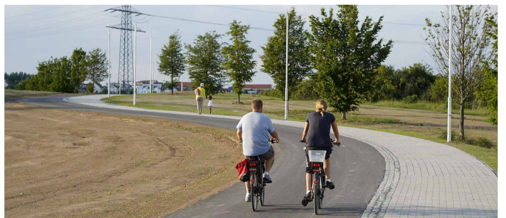
Der neue Fuß- und Radweg schlängelt sich durch den Quellenpark.
