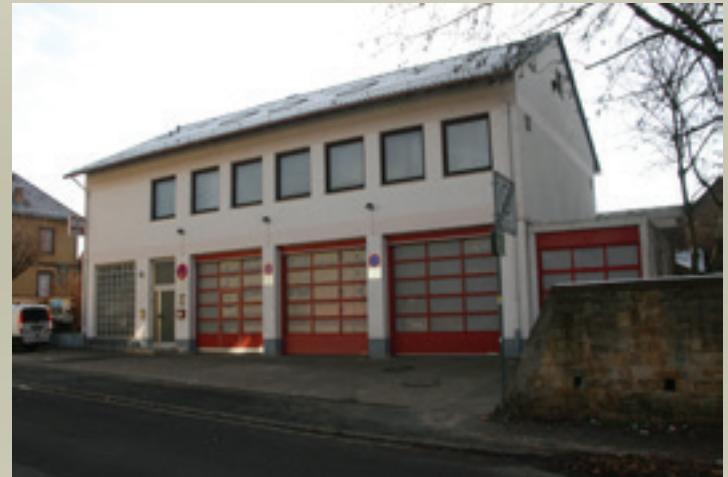
Das aktuelle Feuerwehrhaus mit Gronaris-Saal im 1. OG.
