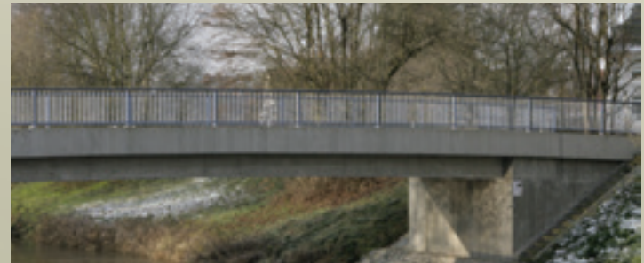
Foto der neuen Brücke, die im November 2013 fertig gestellt und für den Verkehr freigegeben wurde.
